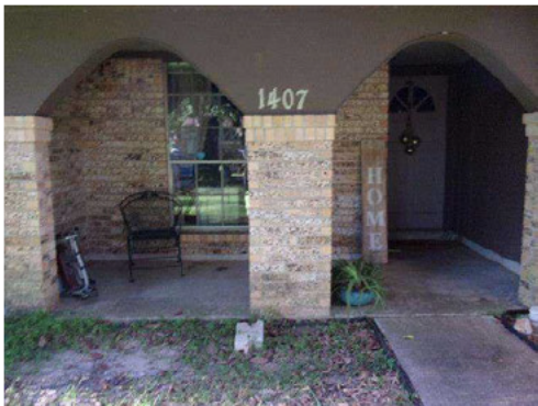
Covd Porch (Concrete)
